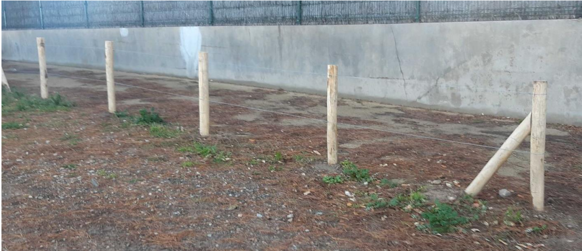
Figure 8 - Clôture bi-fil, exemple à Gâvres, le 9 Novembre 2020
