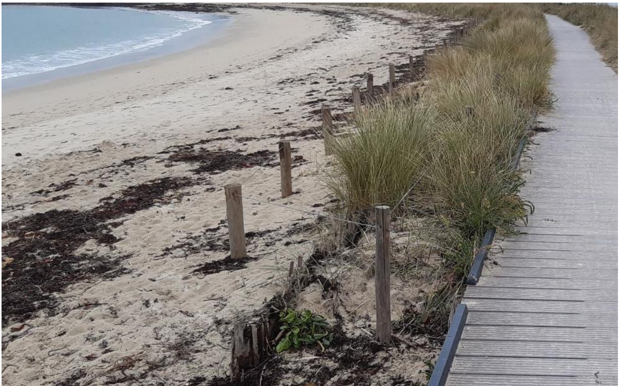
Figure 7 - Clôture mono-fil existante sur l'Anse du Stole, le 15 décembre 2022
